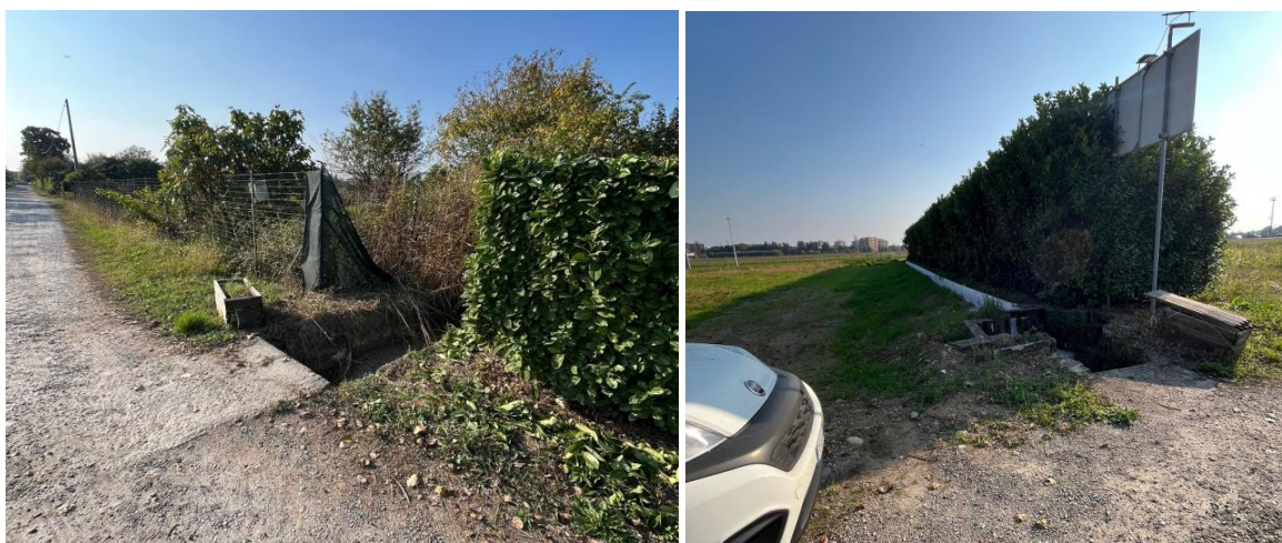
Figura 15. Tombinatura canale 3/4 di Nova – manufatto di ingresso (a sinistra) e di uscita (a destra)
