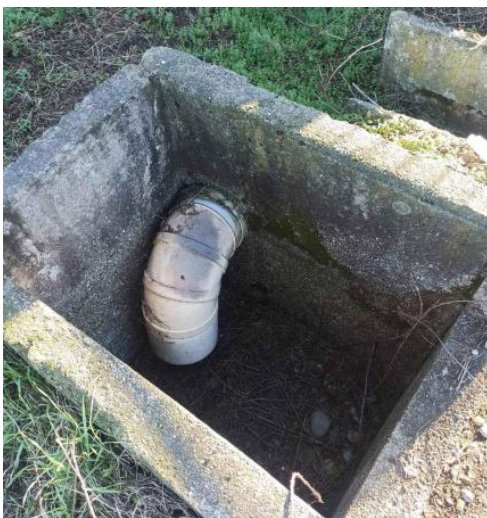
Figura 10. Collegamento con rete di fognatura
