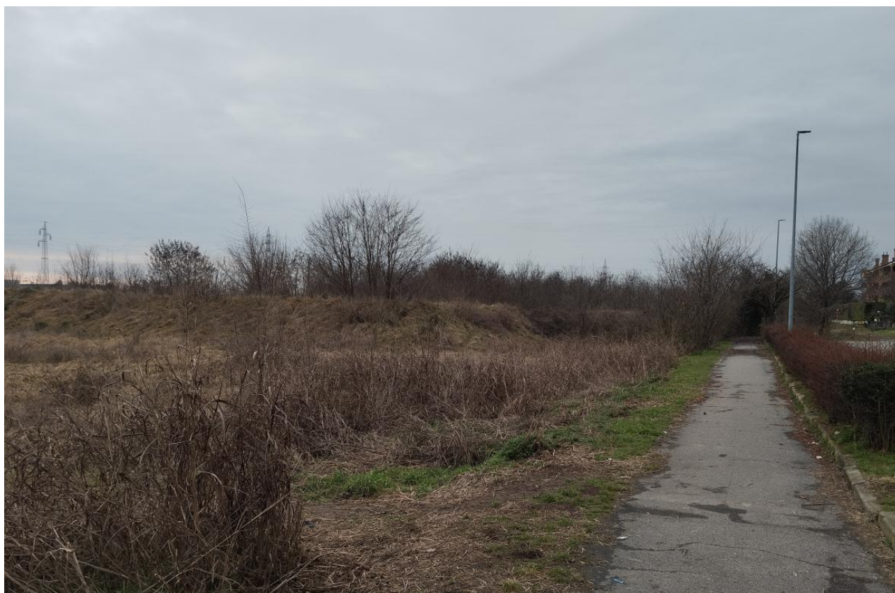
Rilevato in terra all'interno dell'area di progetto
