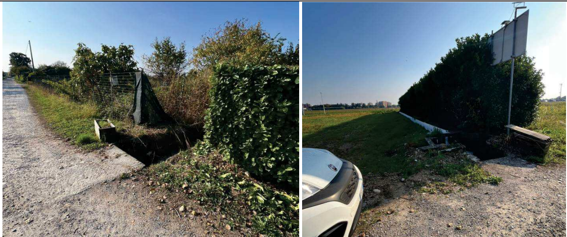
Figura 14. Tombinatura canale 3/4 di Nova – manufatto di ingresso (a sinistra) e di uscita (a destra)
