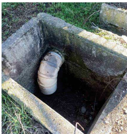
Figura 10. Collegamento con rete di fognatura
