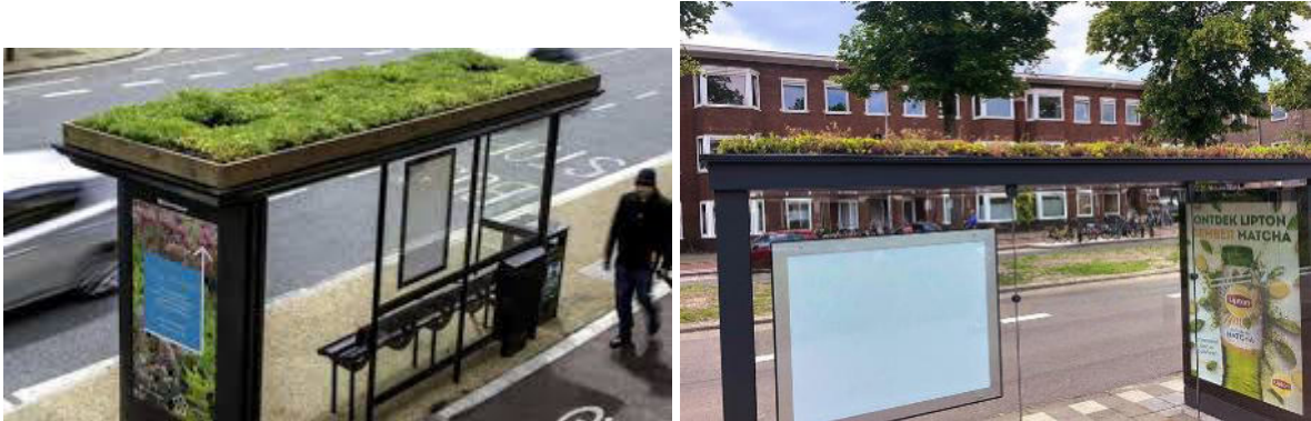
37 Esempi di installazione di pensiline verdi a Leicester e Utrecht.
