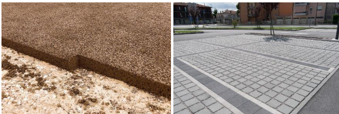
2 Possibili soluzioni di pavimentazioni drenanti.
