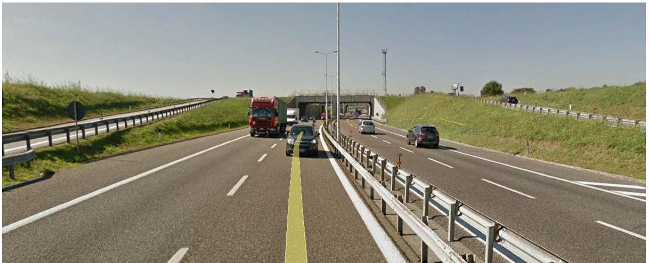
Figura 12 - Tangenziale Nord – doppia carreggiata – rampe di svincolo rotondella di collegamento Via Erba
