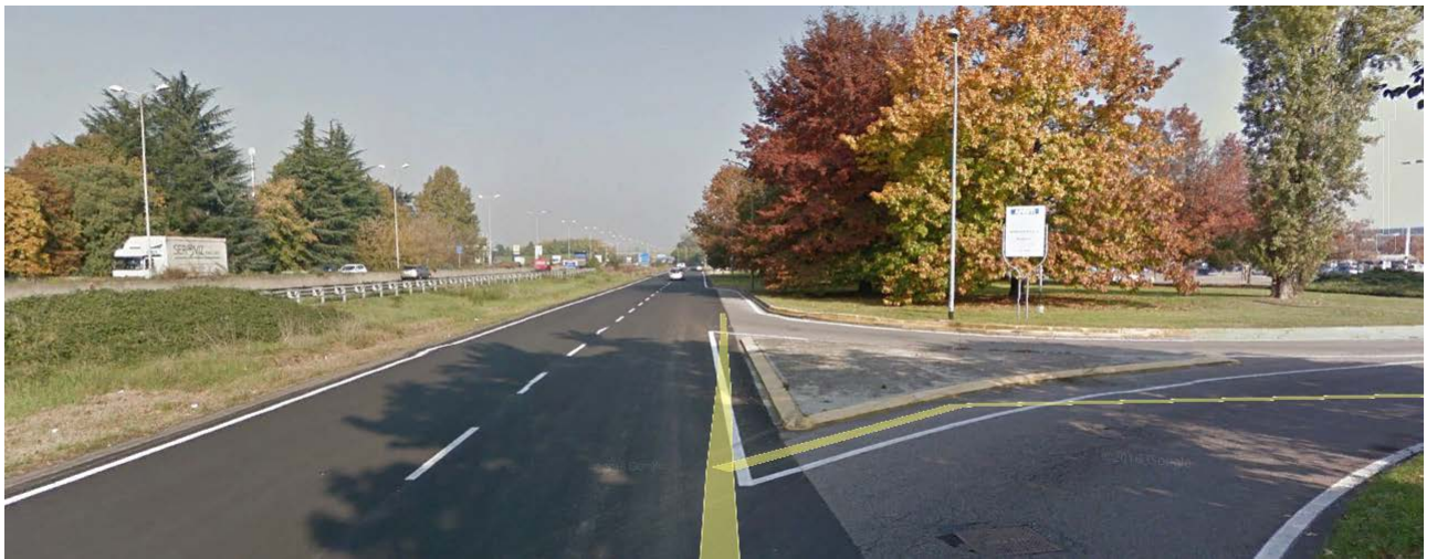
Figura 6 - Controradiale SS 35 – accesso Via Amendola
