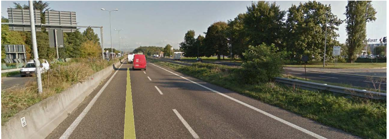
Figura 11 - Superstrada Milano Meda SS 35 – doppia carreggiata e controstrada
