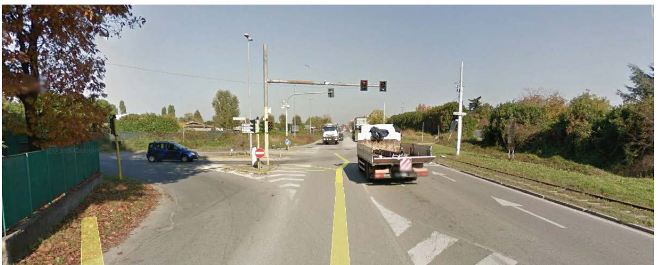
Figura 13 - Via Erba – intersezione con Via Santi
