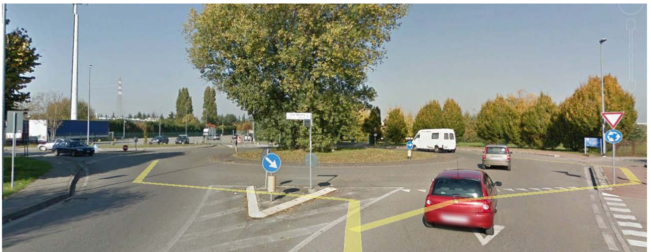
Figura 9 - Via Amendola/Via Toscanini – rotonda esistente
