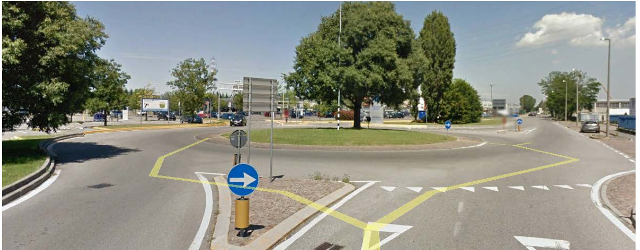
Figura 5 – Via Amendola – rotonda di accesso esistente
