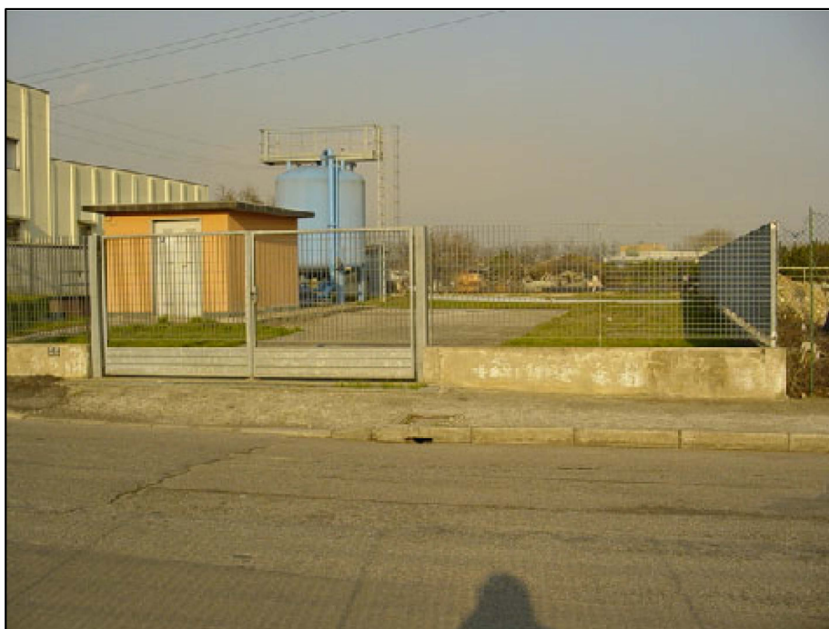
● Pozzo n.50/1-4 - via Galli
