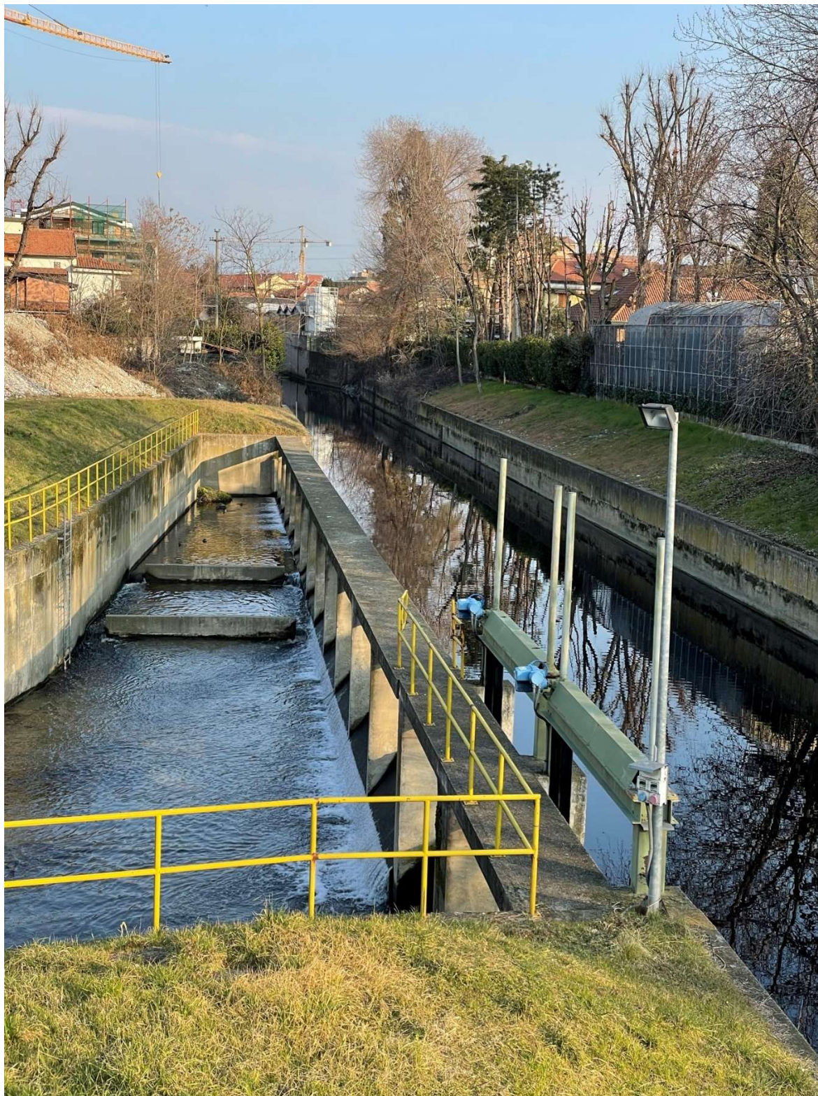
Figura 4.1 – Opera di derivazione del CNSO vista da valle
