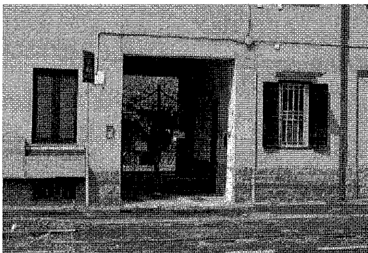
47-P.L.C. via Reali 113-Paderno D
