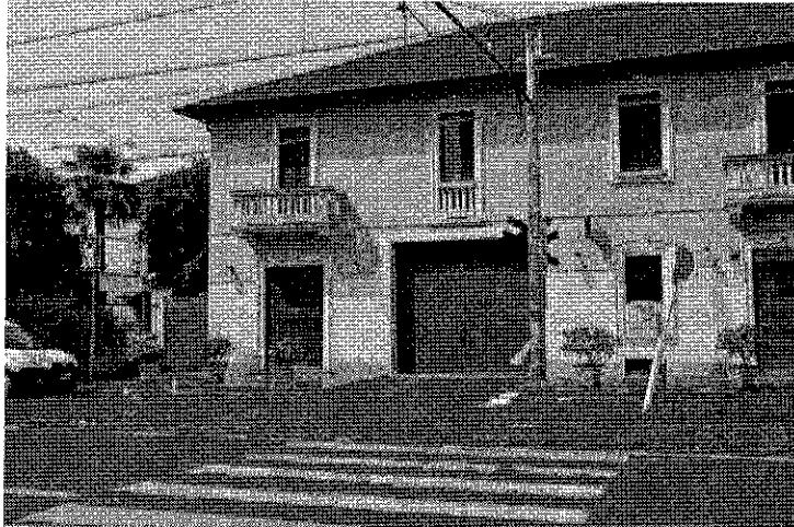
37-P.L.C. via Reali 15-Paderno D
