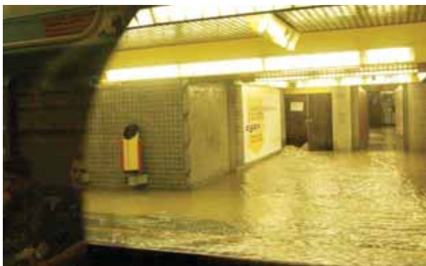
Gli effetti dell'esondazione Seveso del settembre 2010 in metropolitana, linea 3
