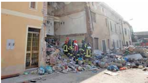
Isorella (BS) danni a seguito di una esplosione per fuga di gas
