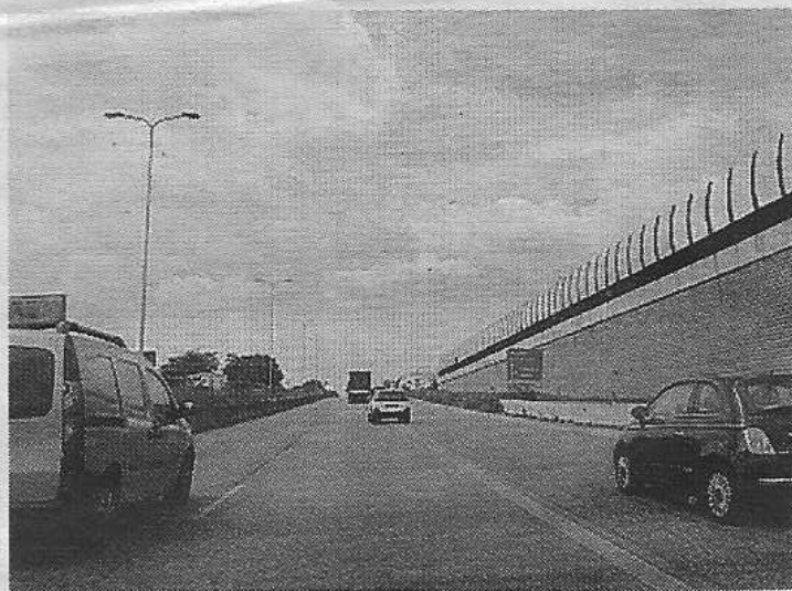
La galleria fonica in costruzione in Rho-Monza
