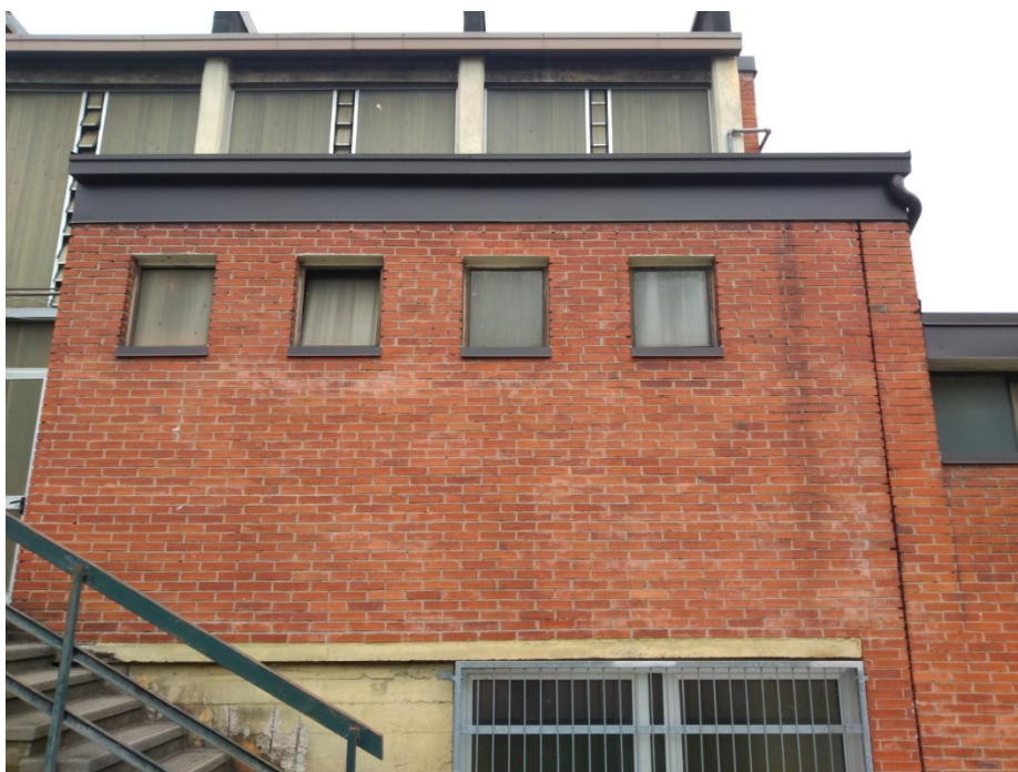
Vista esterna serramenti locale magazzino
