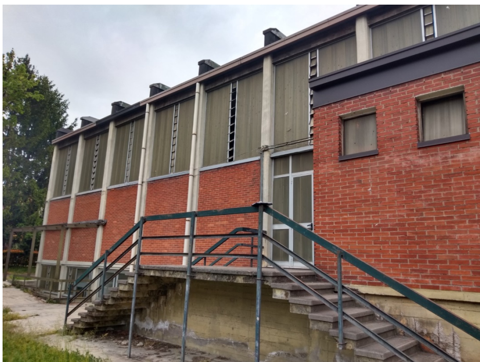
Vista esterna lato Ovest
