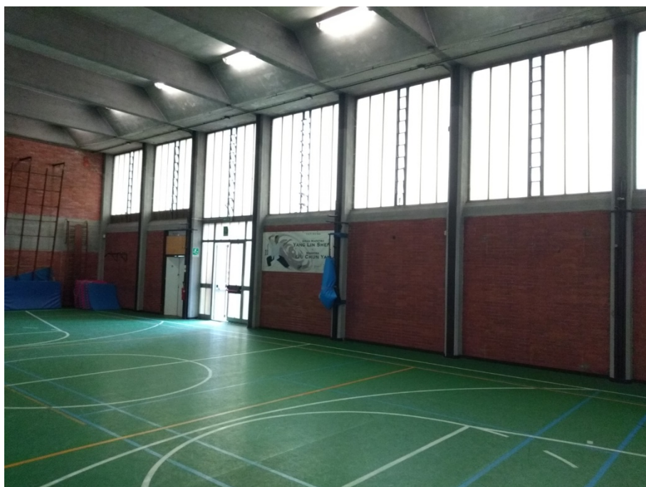
Vista interna lato Ovest
